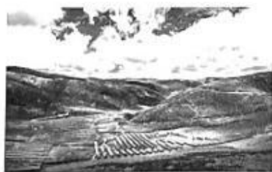
柯拉光伏电站
