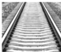
在铁轨下面铺枕木
